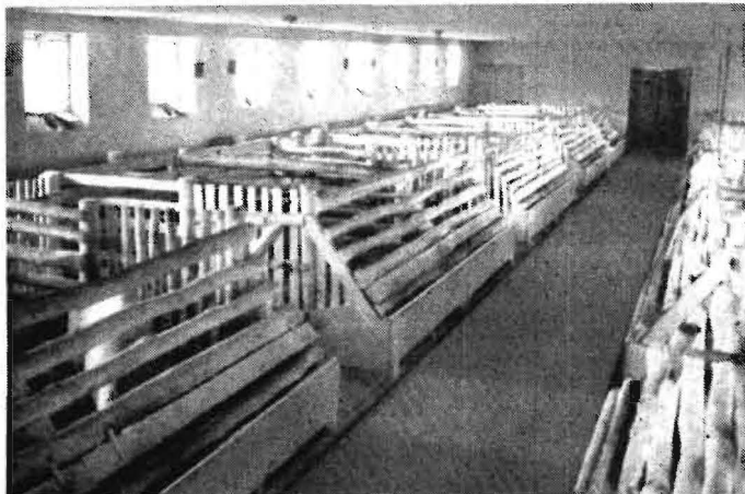
Bild 1. Schweinestall aus den 50er Jahren mit Buchtenbegrenzung durch Holzlatten
