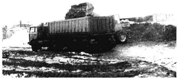
Bild 4. Zuckerrübenabfuhr von einem mit Baustraßenmatten stabilisierten Lagerplatz
