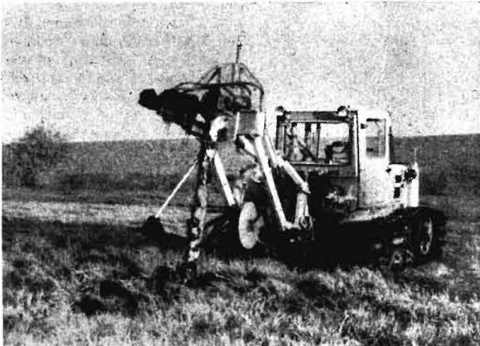
Bild 1. Anbau-Maulwurffräsdräner B721B am Kettenaktor DT-75B im Einsatz auf tiefgründigem Niedermoor
