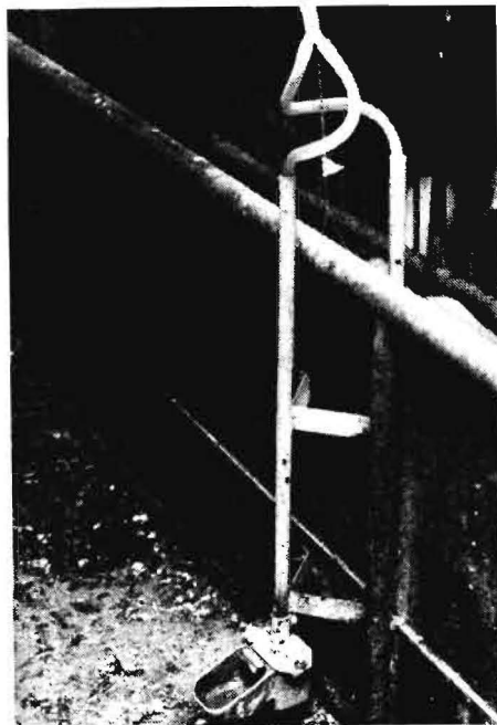
Bild 5. Einbau der Tränkeinrichtung in einem Abferkelstall mit Abferkelbucht T044
