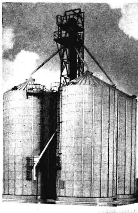
Bild 2. Metallsiloanlage mit 6 Silos K852A (Beschickung und Entleerung mit Becherwerk und Förderband)
