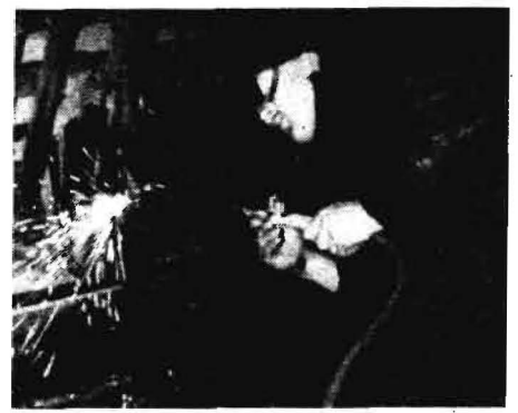
Bild 3. Schweißreparatur an einem Stützbügel im Stall
