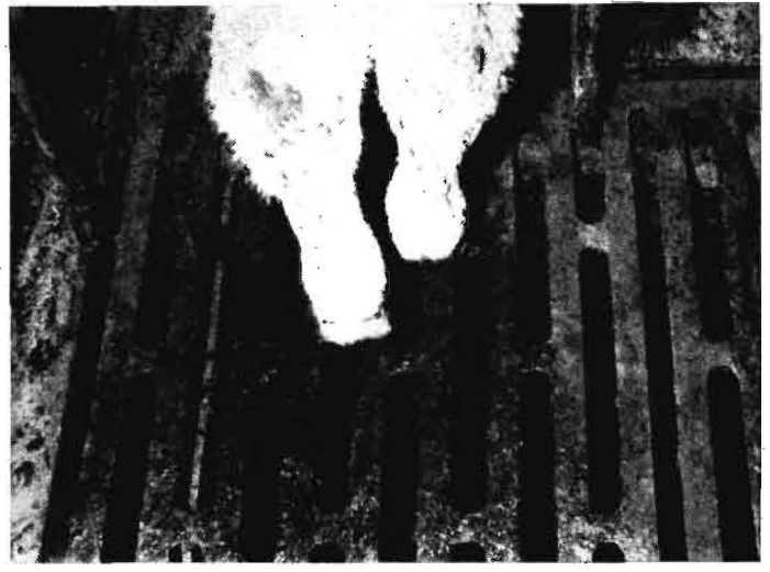
Bild 4. In der Tränkkälberhaltung eingesetzte feingliedrige Graugußroste (Materialaufwand rd. 75 kg/m 2 )
