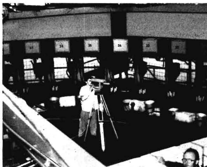
Bild 2. Aufstellen des Laserfluchtungsgeräts LFG 1 im Melkraum
