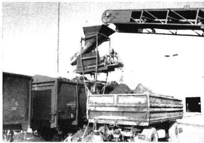
Bild 1. Besatzabscheider mit längerer Siebstrecke am Ende des Bandförderers T 220
