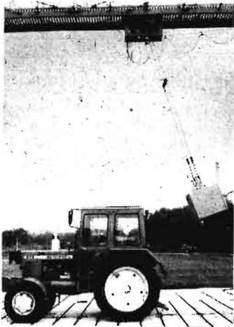
Bild 2. Aufstellung des Traktors für dynamische Belastung
