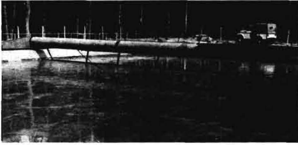
Bild 1. Seilgezogene Rohrbrücke mit Gitterrührwerk zur Homogenisierung von Gülle im Ortbeton-Rechtecklagerbehälter
