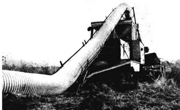
Bild 1. Maschinelles Verlegen von PVC-Spiralrohren
