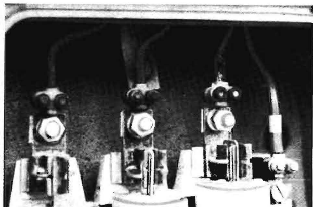
Bild 1. Eine lose Klemmverbindung führte zu starken Schmelz- und Verkohlungserscheinungen
