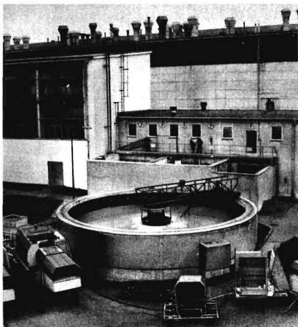
Bild 1. Gesamtsicht der Abwasserreinigungsanlage
