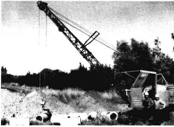
Bild 1. Bagger Typ KM 251 nach Umbau zum Kranbetrieb mit angebrachtem Schwanenhals für den Transport von Dränrohren
