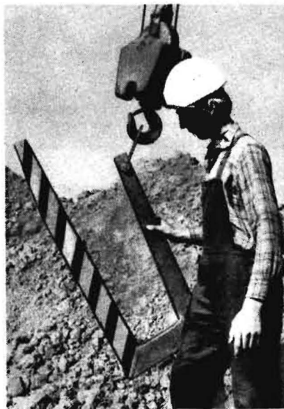
Bild 3. Die Aufnahmevorrichtung — auch „Schwanenhals“ genannt — muß schwarz-gelb gekennzeichnet und am Lasthaken gesichert sein; Schweißarbeiten daran sind nur von einer ausgebildeten Fachkraft vorzunehmen
