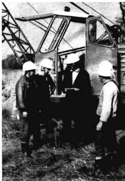
Bild 2. Vor Beginn der Arbeit erfolgt durch den Bauleiter die Einweisung und Belehrung anhand der Sonderregelung und der erforderlichen Arbeitsschutzinstruktion
