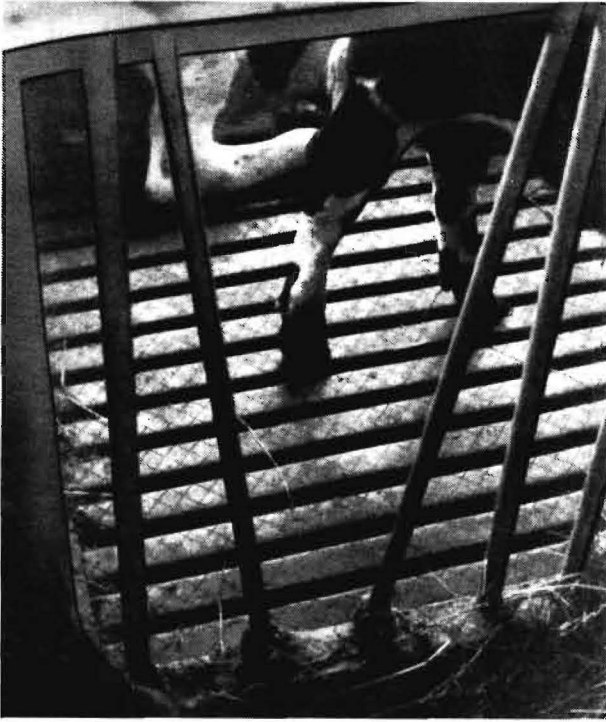
Bild 1. Polyäthylen-Spaltenboden — Standardrost 5 — für Absatzkälber und Jungrinder (Foto: Th. Lüpfer)
