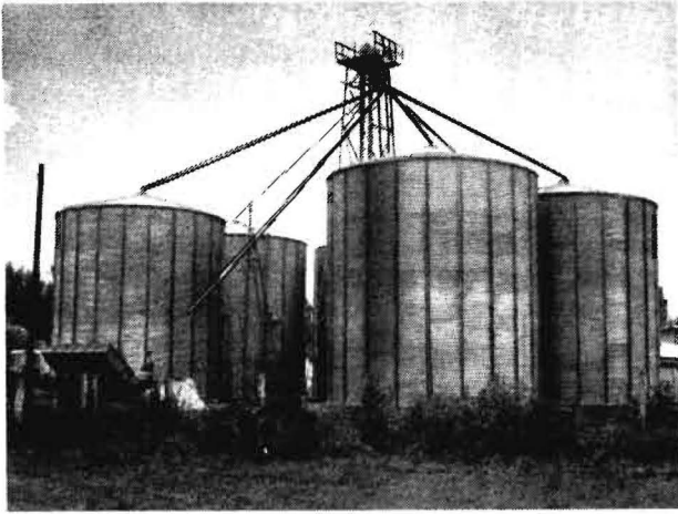
Bild 11. Sechs kreisförmig angeordnete Wellblechsilos mit je 600 t Aufnahmekapazität bilden eine Lageranlage mit einer Gesamtkapazität von 3600 t
