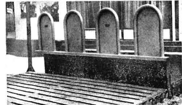
Bild 8. Durchgöngig mit Spaltenhöden aus Beton ausgerüstete Boxen für die Rindermast
