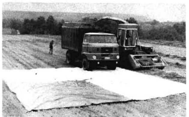
Bild 1. Durchführen der Beladeverlustmessung — Überfahren der ausgelegten Planen durch das Transportmittel
