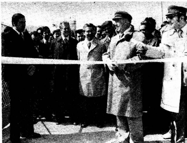
Bild 1. Am Vorabend des 1. Mai 1975 übergab Genosse Gerhard Grüneberg den 1. Bauabschnitt der IRIMA Hohen-Wangelin an die künftigen Nutzer
