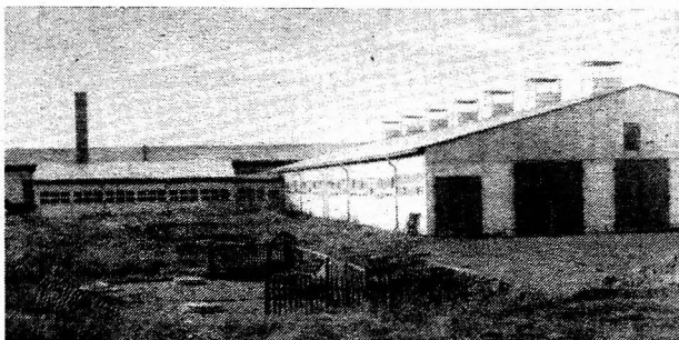
Bild 1. Ansicht des Typenstalls L 203 mit Milchhausanbau
