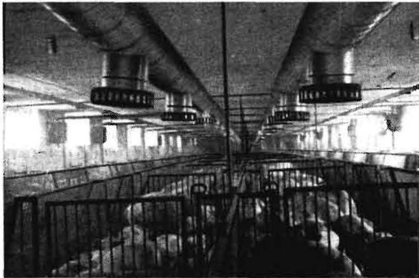
Bild 2. Neue Belüftungsanlage im Schweinemaststall als Überdrucksystem, jeder der beiden sichtbaren Rohrstränge besteht aus zwei 50 m langen Kanälen
