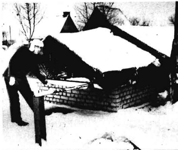
Bild 3. Die Abdeckung des Lüftungsschachtes läßt sich gesondert verschieben
