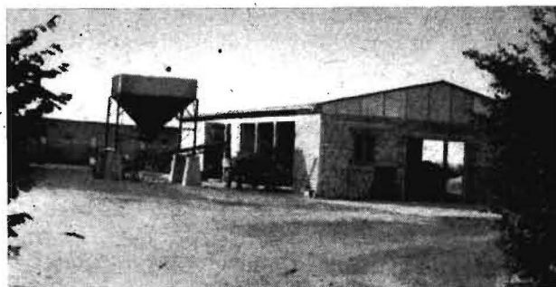
Bild 1. Süd- und Ostseite der Halle
