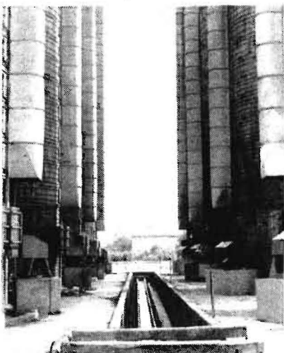
Bild 5. Montagehöhen bis zu 24 m werfen bei den Hochsiloanlagen besondere Arbeitsschutzprobleme auf, deshalb wurde zur Montagetechnologie auch ein zentrales Schutzgütegutachten eingeholt
