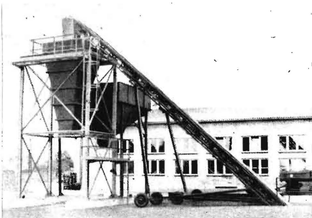
Bild 5. Trichterteil des Dosierbehälters, Typ Mölkau, mit unterfahbarem Untergestell
