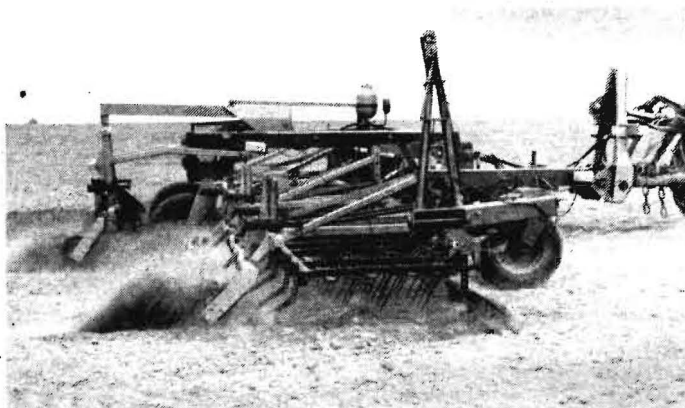
Bild 5. Einsatz der Kombination mit Federzinken zur flachen Saatsbettbereitung
