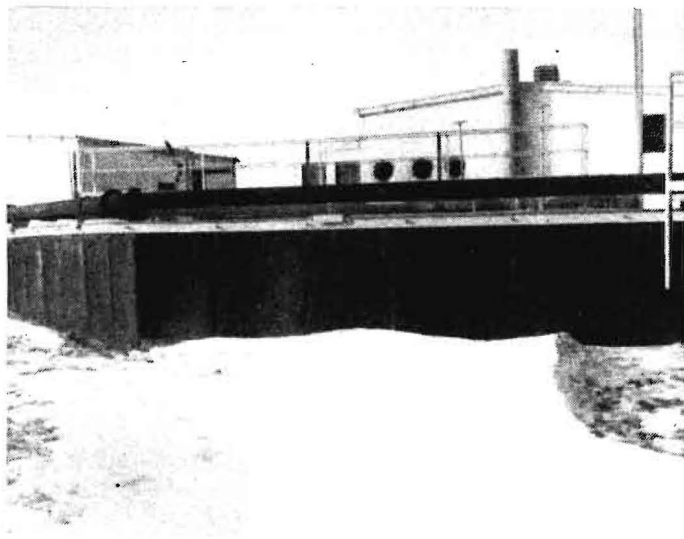
Bild 2. Güllelagerbecken 2 mit Luftleitung
