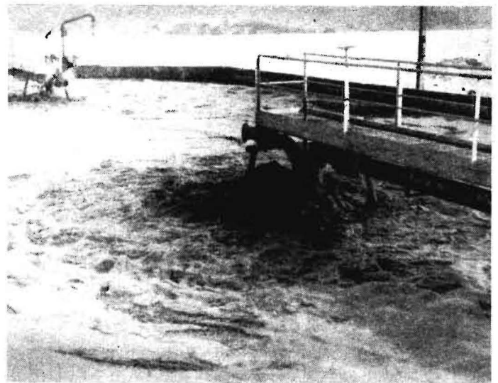
Bild 3. Homogenisierung durch unten austretende Luft
