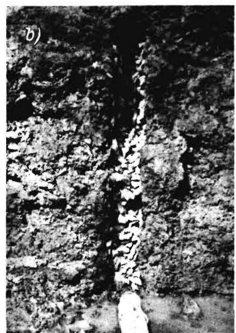
Bild 4. Profilbilder der Sickerschlitzdränung mit Welldränrohr: a) Material: Splitt, Schlitzhöhe 60 cm, Schlitzbreite 10 cm b) Material: Rohkiessand, Schlitzhöhe 30 cm, Schlitzbreite 11 cm
