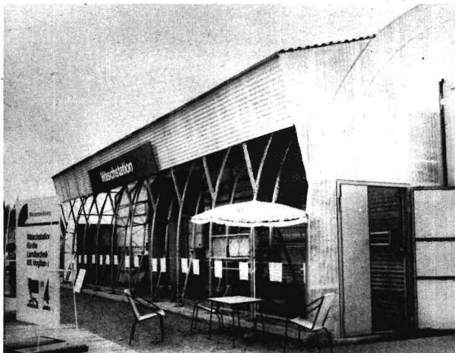
Bild 4. Waschstation: bestehend aus einer Stahlleichtbaukonstruktion, die eine plastverkleidete Spritzkabine umhüllt, in der die programmgesteuerte Waschanlage TGW-L arbeitet
