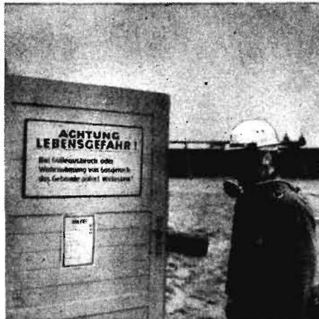
Bild 3. Nach 15minütiger Durchlüftung leuchtet die Signallampe auf, die Tür wird entriegelt, eine Arbeitskraft betritt die Anlage zur Luftmessung
