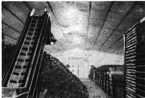
Bild 2. Innenansicht mit Boxen- und Haufenlagerung und eingeschobenen Polystyrolplatten
