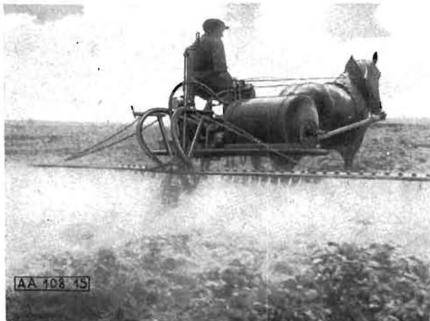
Bild 15 Schaumnebelspritze P/SG 6 (PSN 6)
