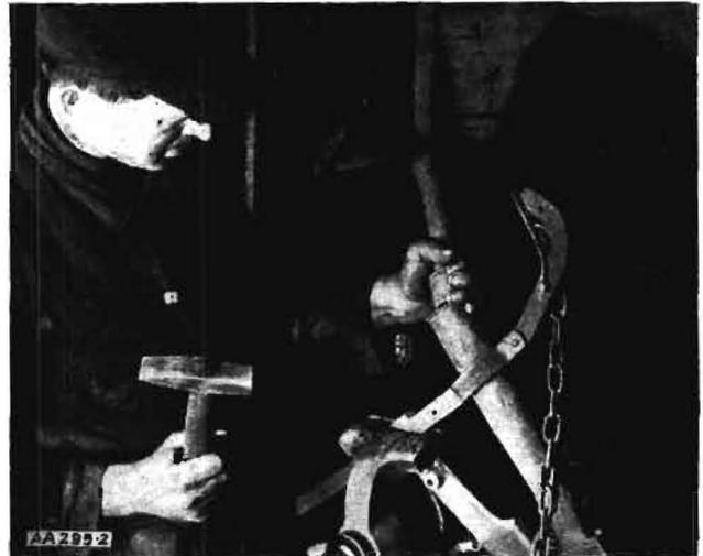
**Bild 2** Wegen Mangel an Ersatzteilen, bedingt durch die fehlende Normung, stellt der Dorfschmied ein solches in mühevoller Handarbeit selbst her. Unser Bild zeigt: Ein Lauf für eine Drilltüte wird erneuert
