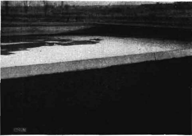
Bild 1 Der ausgefallte Klärschlamm wird auf besondere Schlamm-trockenplätze gefördert. Das hintere Becken dieser Großkläranlage ist frisch beschickt, das vordere enthält Schlamm, der bereits trocken ist. Wenn er stichfest ist, wird er vom Bagger ausgehoben und an Gärtner und Bauern verkauft
