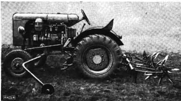
Bild 4 Normag-Ackerschlepper mit durch pneumatischen Kraftheber bedientem Pflanzlochgerät. Arbeitskolben des Krafthebers ist in Gehäuse eingebaut
