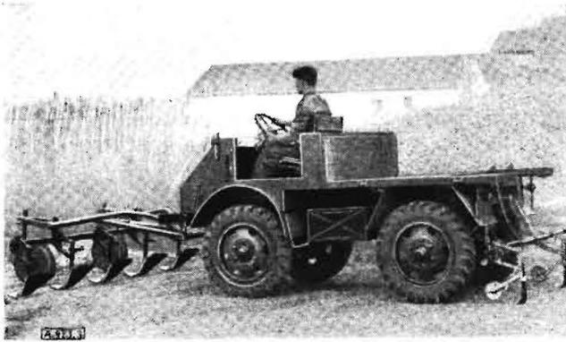
Bild 3 Der Unimog-Schlepper der Fa. Daimler-Benz mit vorne angebautem Häufelgerät, durch pneumatischen Kraftheber aushebbar
