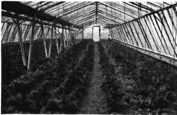
**Bild 3** Thermos-Bauweise. Die Heizungsanlage bildet gleichzeitig das Traggerüst
