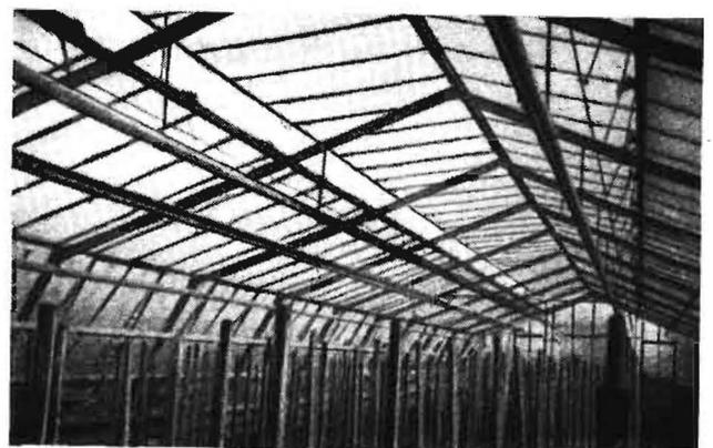
**Bild 8** Verzinkte Eisenkonstruktion mit moderner Lüftung
