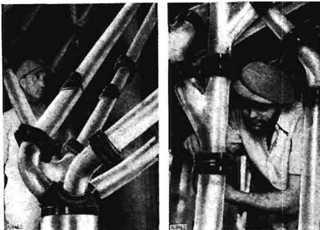
Bild 2 und 3 In der neuen Mühle in Netolizy wurden 1 km Kristall-Glasrohre eingebaut. Diese Rohre sind gut durchsichtig, das Glas entspricht allen gestellten Anforderungen und ist dabei sehr billig und genügend fest. In bezug auf Festigkeit ist es den früher verwendeten Materialien – Holz und Blech – überlegen
