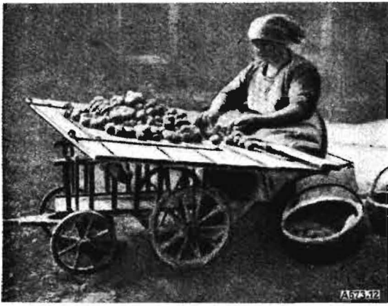
Bild 12 Kartoffelauslesetisch in einfachster Form
