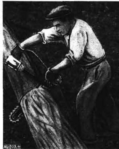
Bild 4. Schneiden der Stämme mit der Säge ZNIIMÄ K-5
