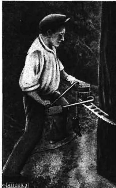
Bild 3. Ansägen der Bäume mit doppeltem horizontalem Schnitt mit der Säge ZNIIMÄ K-5
