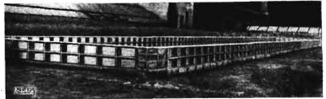
Bild 3. Kasten aus Glassteinen im Bau, es fehlt noch der First und die Seitenabdeckung
