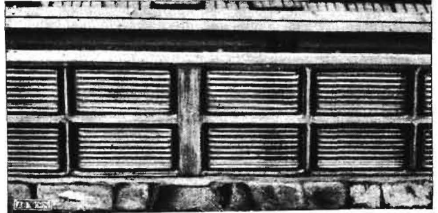
Bild 4. In der Mitte die eingemauerte Kiefernholzlatte mit Gummipufferung
