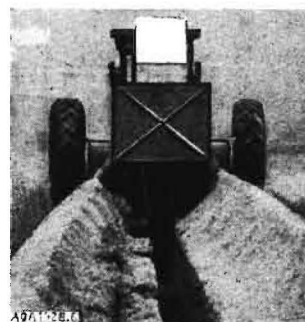
Bild 6. Drängraben in Sandboden, mit Horneburger Dränbagger hergestellt
