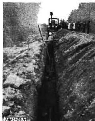
Bild 4. Rohrgraben in einer Landstraße mit verlegter Trinkwasserleitung. Bodenaushub durch Homberg-Grabenbagger
