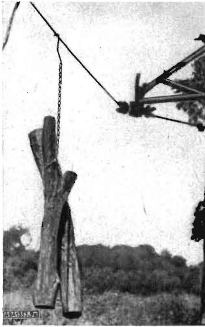
Bild 13. Lassokabel beim Schichtholztransport an der Umlenkrolle
