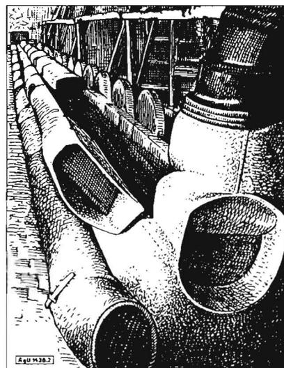
Bild 2. Blick auf die abgeklappten Hauben in der Futtergasse, den Luftabfuhrkanal und die Rohrleitung zur Füllung der zweiten Hälfte der Futterrinne
