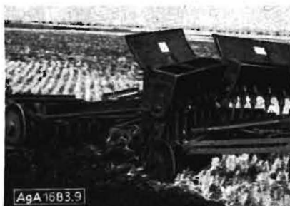
Bild 9. Scheibenegge mit Antriebsmechanismus für die Säeinrichtung
