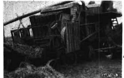
Bild 3. Selbstangefertigter Radschutz an einer Strohpresse
