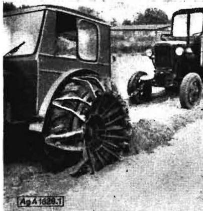
Bild 1. Klappgreifer im Betrieb
