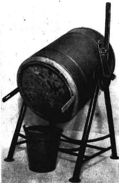
Bild 2. Der Dämpfer wird zurückgekippt, der Deckel abgenommen und durch Schrägstellung des Dämpfers das Wasser abgelassen. Nach Entfernung des gelochten Rostes läßt sich dann — ebenfalls durch Kippen — der Dämpfer entleeren
