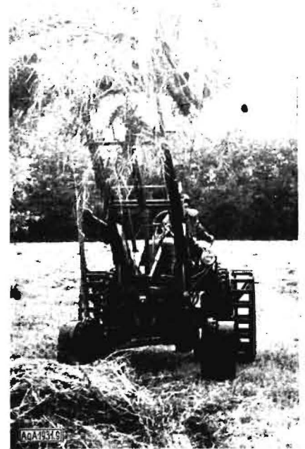
Bild 9. Die Heuraffer-Hubgabel am „Maulwurf“ bei der Grasmähd im Spreewald erforderte auch Radverbreiterungen an den Vorderrädern
