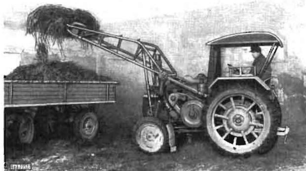
Bild 1. Schlepperfrontlader beim Laden an der Düngestätte
